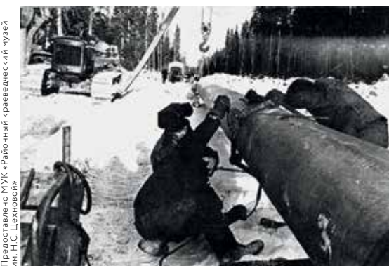
ЕЩЕ ОДИН СТЫК НЕФТЕПРОВОДА ШАИМ – ТЮМЕНЬ
