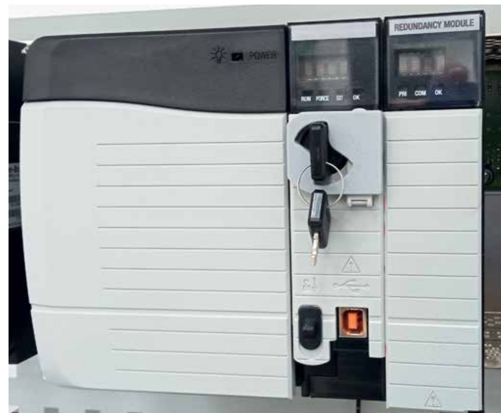
МОДУЛЬ ПЕРЕКЛЮЧЕНИЯ РЕЖИМОВ ПЛК С УСТАНОВЛЕННЫМ БЛОКИРАТОРОМ
