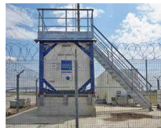
УСТАНОВКА ДЛЯ ВВОДА ПТП В НЕФТЕПРОВОД КТК
