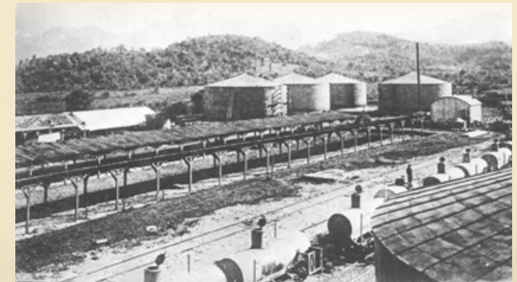
Участок трехкилометрового нефтепровода в Батуми, построенного по проекту Шухова, 1886. Фото из архива РАН
