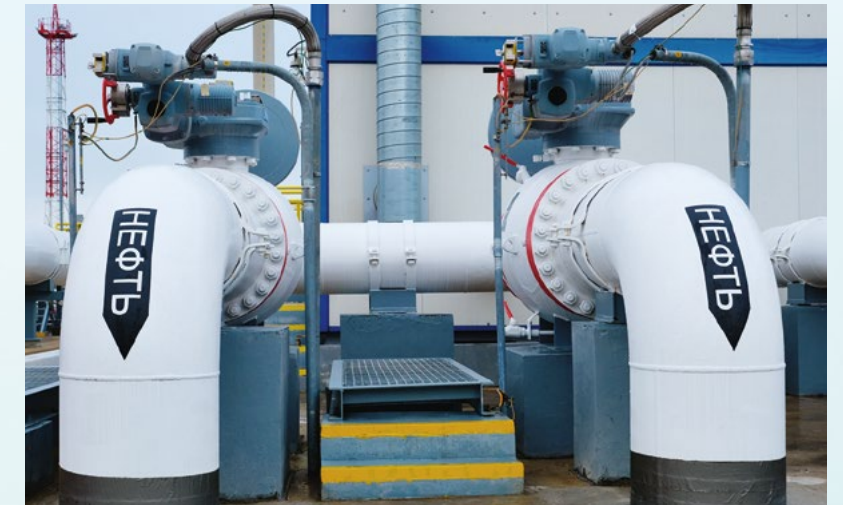
Работа проводилась без вывода НПС из режима перекачки
