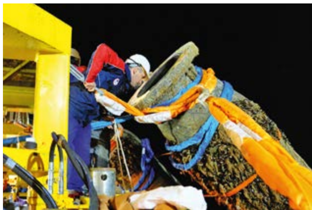
2022 год. Замена танков плавучести ВПУ на Морском терминале
