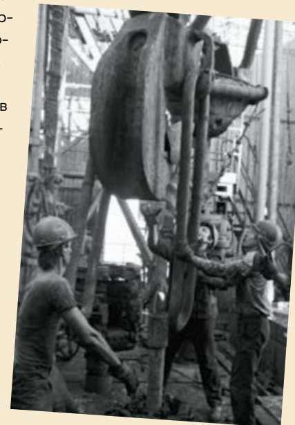
Строительство Тенгизского нефтегазового месторождения, 1988 год
